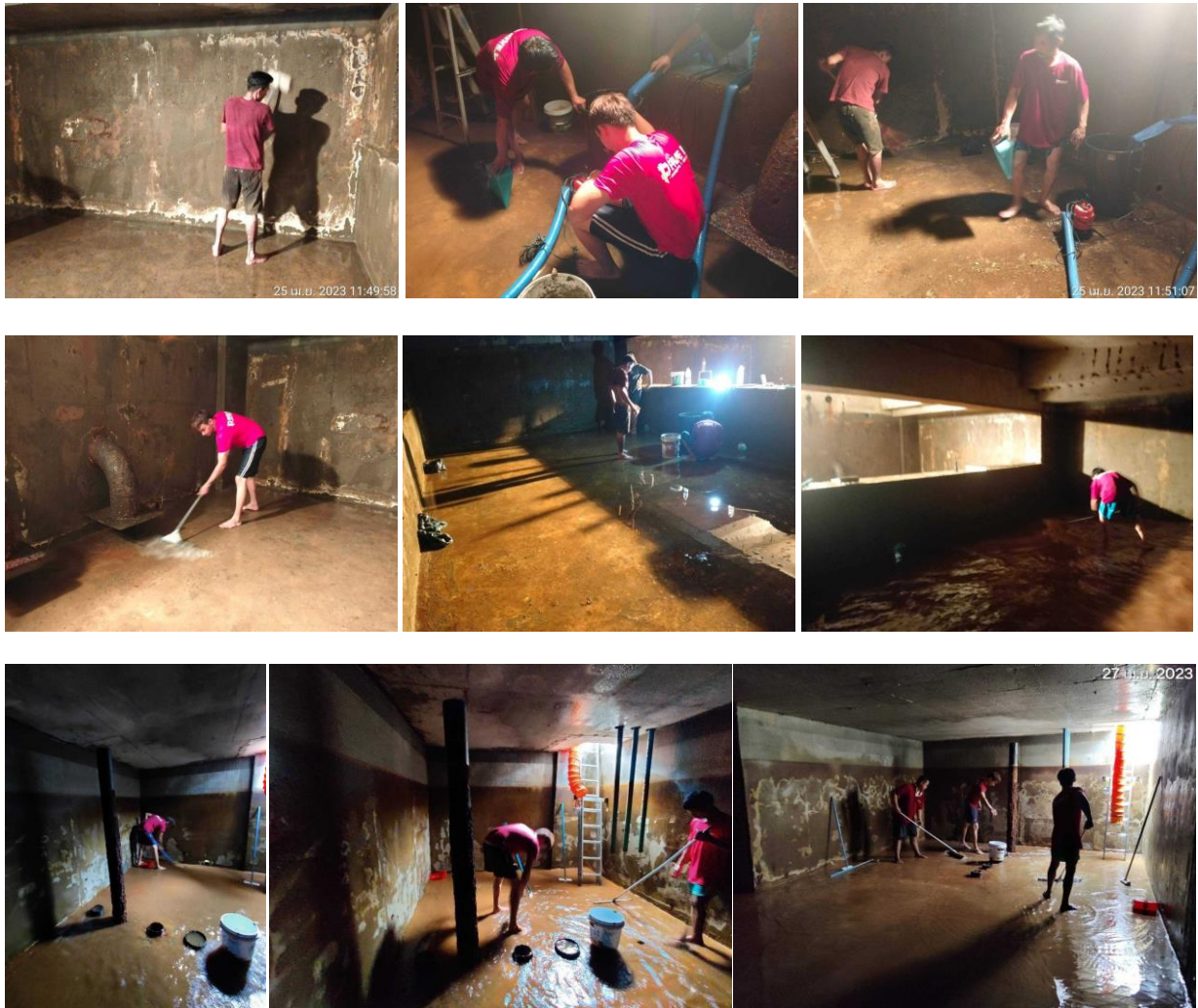
รูปที่ 2-38 ล้างถังเก็บน้ำชั้นใต้ดินและชั้นดาดฟ้า
